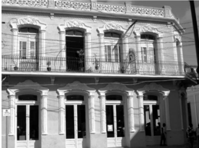
IMAGEN 6. En los edificios de carácter mixto se acondicionan servicios en la planta baja y se rehabilitan las viviendas de la planta alta. Edificio de “La Gran Señora”, plaza de los Trabajadores. Fotografía de Lourdes Gómez Consuegra.
