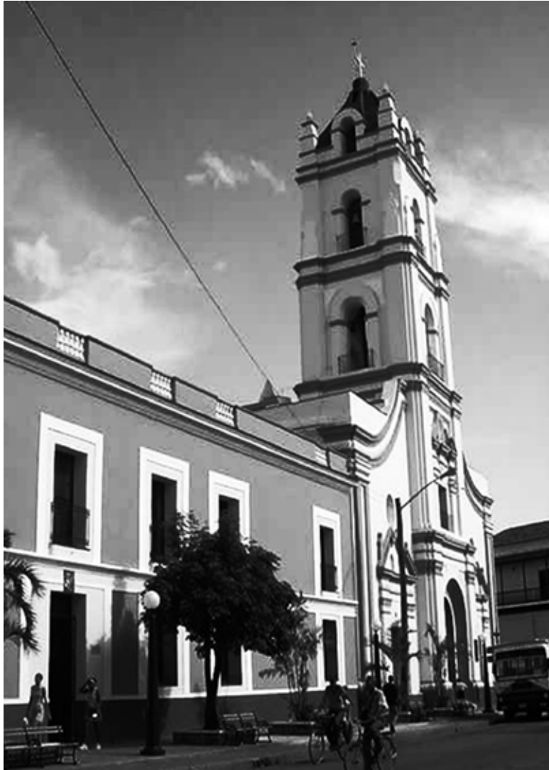
IMAGEN 2. En los últimos diez años se han restaurado o rehabilitado en Camagüey todas las iglesias del centro histórico y en general de la provincia. Iglesia-convento de Nuestra Señora de la Merced. Fotografía de Lourdes Gómez Consuegra.
